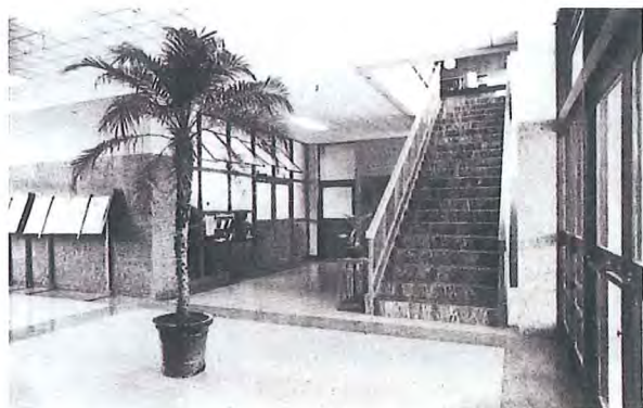
蔵本分館玄関ホール(昭38.2)▶
