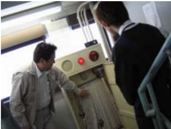
消防訓練(蔵本分館)(3 月)消火栓説明
